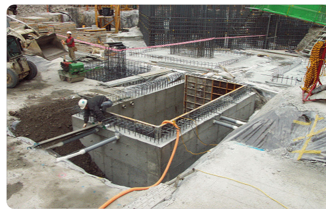
排水管設置作業が難しいし配管破損の恐れが高い
