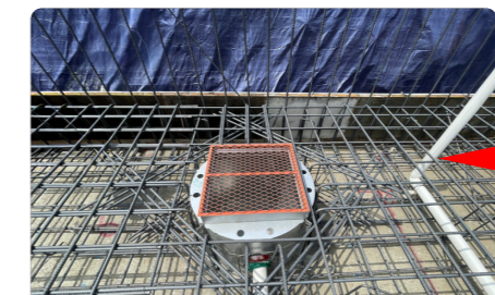
4. 上部鉄筋固定
