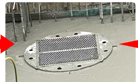
5. 基礎打設完了
