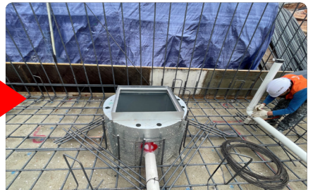
3. 下部鉄筋固定
