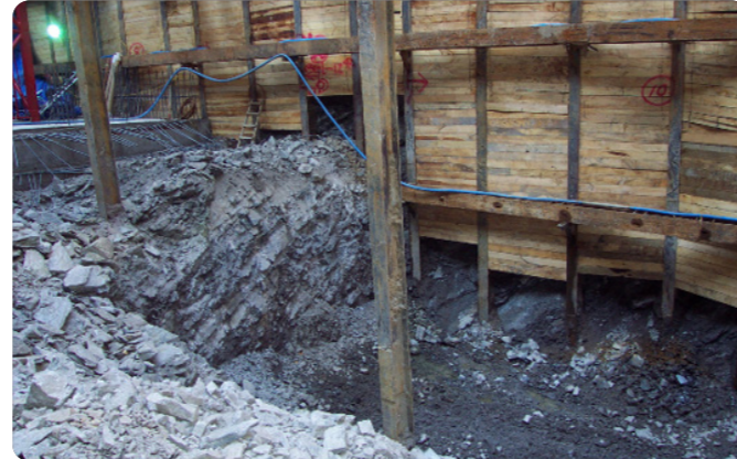
地盤が岩盤の場合根切りが難しい根切りが難しい
